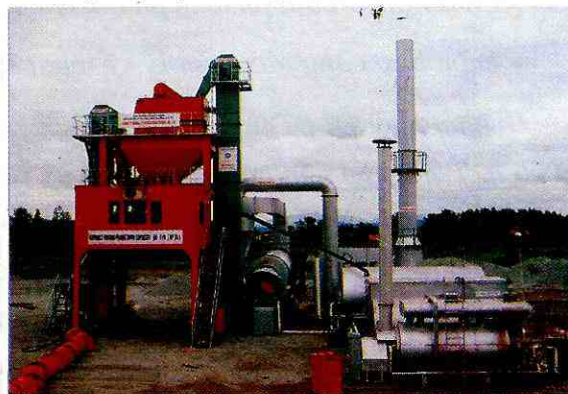
Trạm trộn bê tông nhựa.
