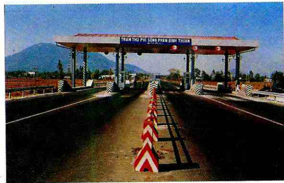
Trạm thu phí Sông Phan - Bình Thuận.
