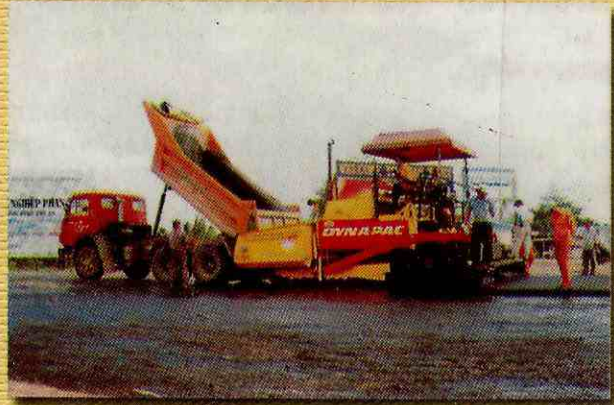
Thảm bê tông Asphalt QL1 Công ty Công trình Giao thông 677
