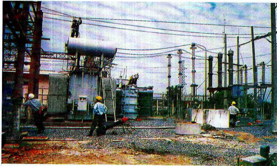
Lắp đặt thiết bị 110 KV Phan Thiết.
